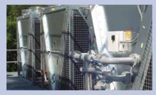
Холодильные машины YWWA могут эффективно работать при высоком давлении в конденсаторе, необходимом для «сухого охлаждения».
