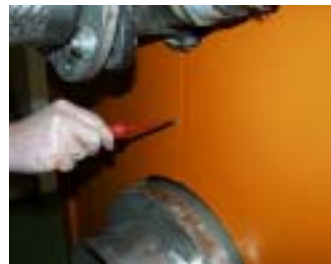
Винтовое соединение частей обшивки
