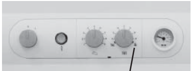
Положение «сервисный режим трубочист»
