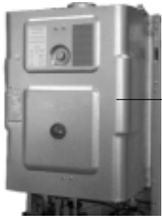
Корпус камеры сгорания (только у GG-2E-S)
