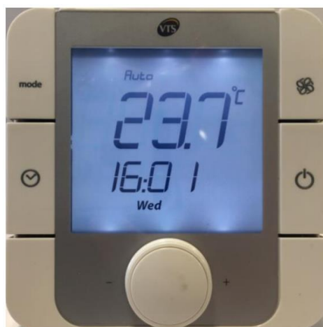
Рис. 31. Приточно-вытяжная установка в режиме включения.
