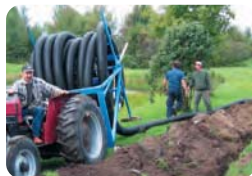
Поставка на место выполнения работ в соответствии с заказом; монтаж непосредственно из бухты.
