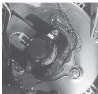
**Sonda temperatura fumi:** questa termocoppia rileva la temperatura dei fumi mantenendo il funzionamento oppure arrestando la caldaia quando la temperatura dei fumi sale sopra il valore preimpostato.
