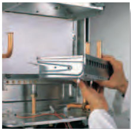
Демонтаж горелки выдвиганием вперед без отключения подачи газа
