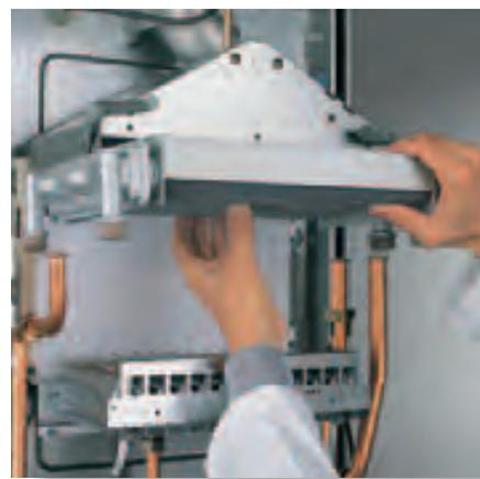
Демонтаж теплообменника выдвиганием вперед
