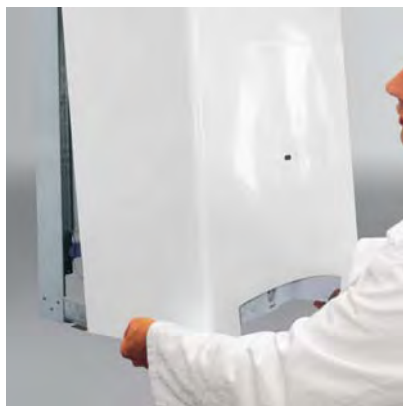
Обшивка котла снимается простыми движениями
