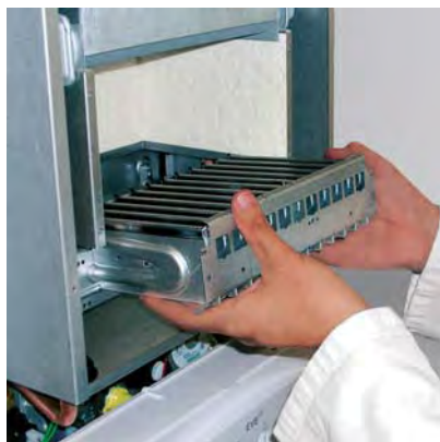
Демонтаж горелки выдвижением вперед без снятия газового коллектора
