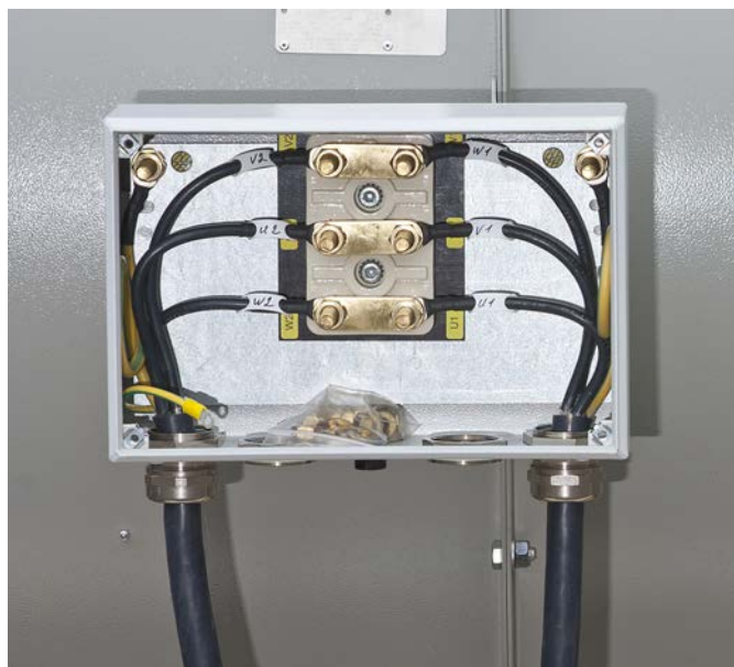
Рис. 25: Клеммная коробка на осевом вентиляторе.
