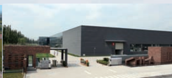
Производство в Тяньцзине
