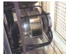
Секция вентилятора с ЕС-двигателем
