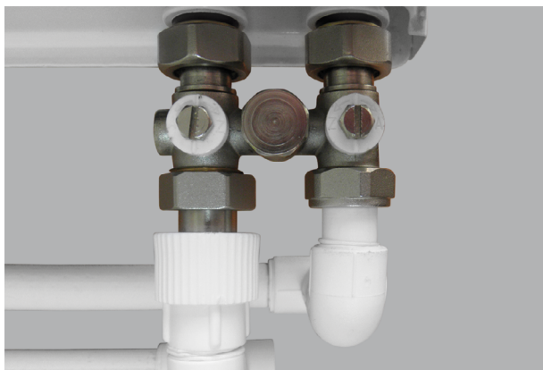
Сравнительное соединение с применением комбинированной муфты и штуцера-евроконуса
