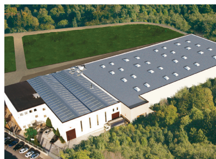
● Завод в Силс (Испания)
