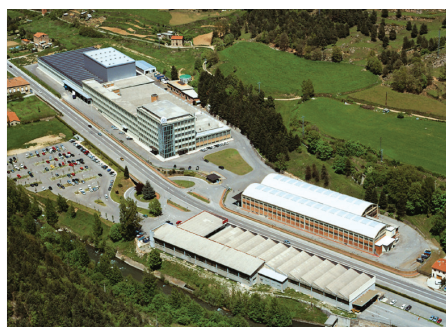
● Производственный комплекс в Риполе (Испания)
