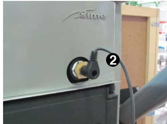
Рис. 34 Разъем предохранительного термостата
