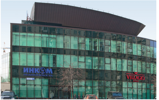
Офисный центр компании «ИНКОМ», г. Москва
