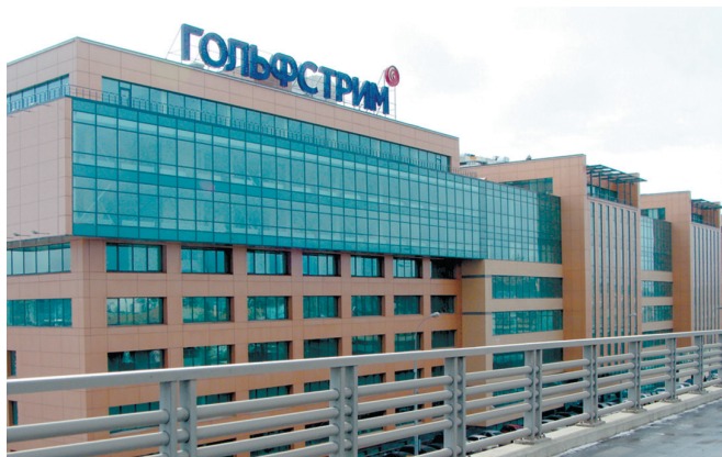
Офисный центр «Гольфстрим», г. Москва
