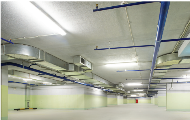
Подземная двухуровневая автостоянка, г. Королев
