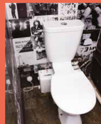
SANIBEST® Pro установлен в туалете в подвальном помещении
