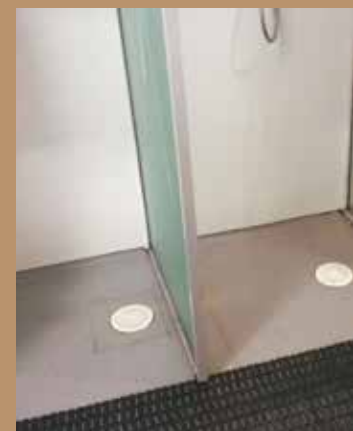
Душевые в подвальном помещении
