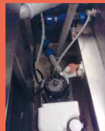
Установленная насосная станция SANICOM® 1
