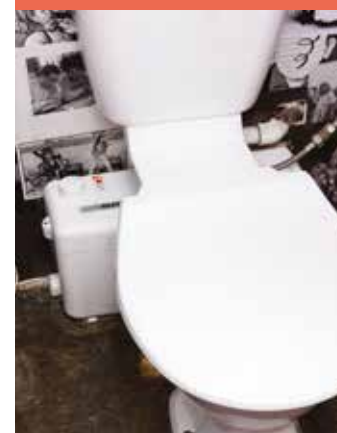
SANIBEST® Pro установлен в туалете в подвальном помещении
