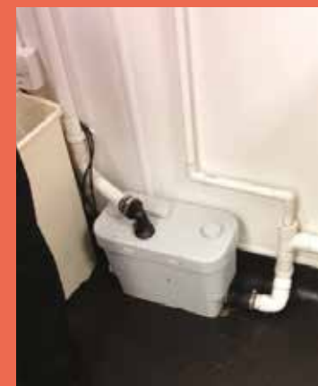
Насос SANISPEED® установлен в подвальном помещении
