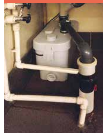
Насос SANISPEED® установлен под раковиной
