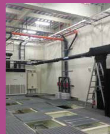
Две насосные станции SANICUBIC® 2 Pro установлены в подвальном помещении для отвода сточных вод
