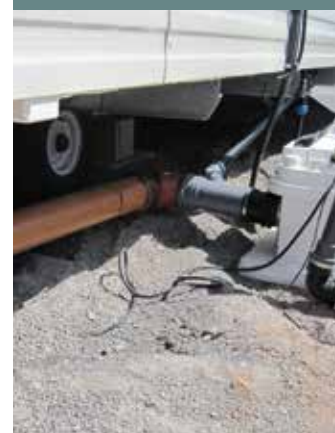
Смонтированная насосная станция SANICUBIC® 2 Pro
