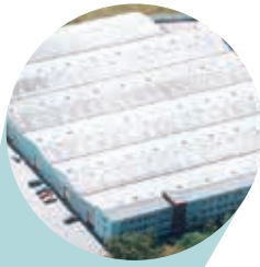
NiroSan® Edelstahlrohrwerk in Berlin
