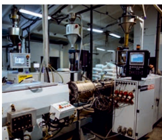
Цех по производству канализации
