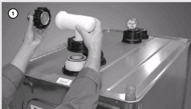
Установка отдельного резервуара
