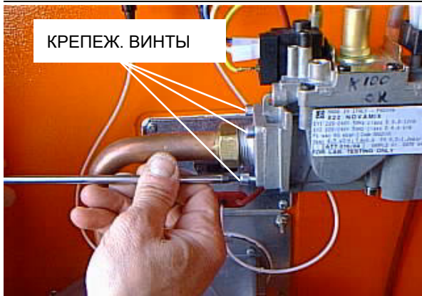
Рисунок 34 – Крепежные винты газового фланца
