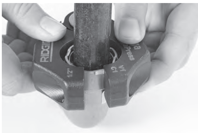
Rysunek 11 – Montaż pierścienia zaciskowego na okuciu
