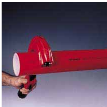
Рис. 15 1. Отрезать трубу по размеру под прямым углом
