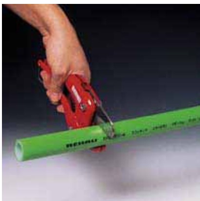
Рис. 7 1. Отрезать трубу по размеру под прямым углом
