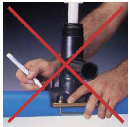
Рис. 55 Не используйте тройник под врезку в качестве шаблона для отметок
