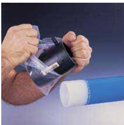
Рис. 32 6. Вынуть электросварную муфту из полиэтиленового пакета
