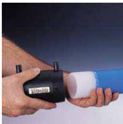
Рис. 33 7. Надвинуть ЭСМ-муфту на конец трубы
