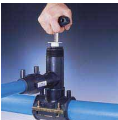
Рис. 48 9. После завершения гидравлического испытания торцовым ключом на 12 завернуть фрезу в тело трубы
