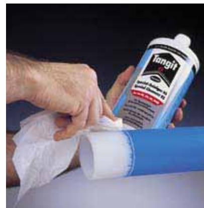
Рис. 31 5. Зона сварки не должна быть пыльной и жирной, при необходимости следует очистить поверхность очистителем
