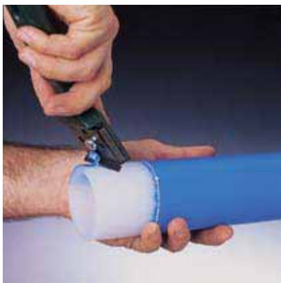
Рис. 29 3. Полностью очистить покрытие, не заступая за отмеченный диапазон
