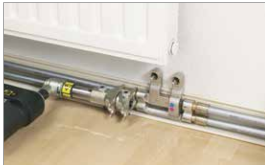
Рис. 16-33 Соединение с помощью подвижной гильзы, трубы диаметром 16 мм, с крестовиной из комплекта SL- RAUTITAN 16 - 12 - 16
