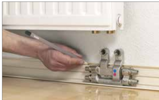
Рис. 16-32 Определение длины трубы
