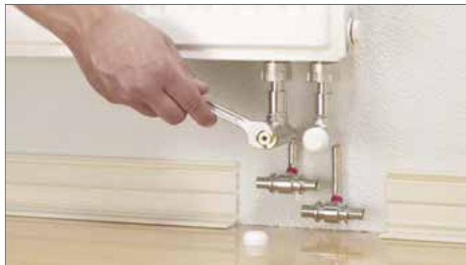
Рис. 16-45 Затяжка резьбозажимного соединения
