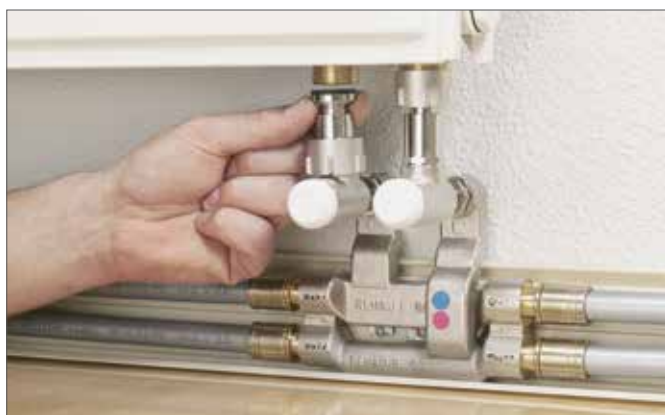
Рис. 16-26 Подключение угловых телескопических резьбозажимных соединений
