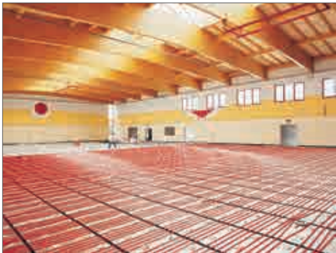
Рис. 11-13 Система напольного отопления виброполов со стандартным распределительным коллектором
