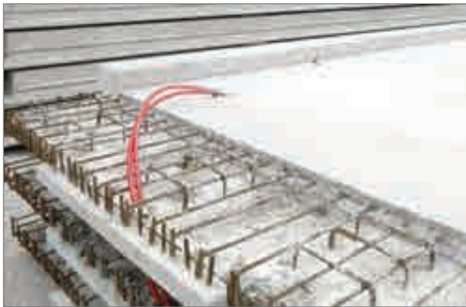
Рис. 9-4 Система REHAU ВКТ из полуготовых модулей
