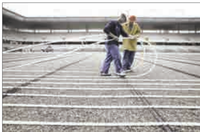
Рис. 13-3 Укладка отопительных труб
