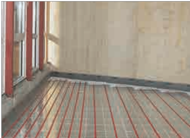
Рис. 4-53 «Сухая» система укладки труб
