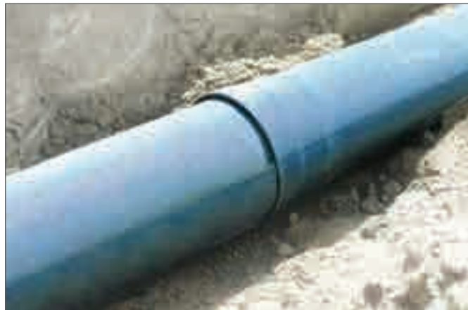
Рис. 13-2 Укладка дренажа на игровом поле
