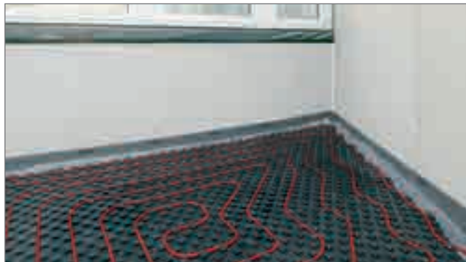
Рис. 4-10 Маты с фиксаторами Varionova с шагозвукоизоляцией 30-2 снизу
