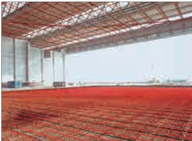
Рис. 10-1 Обогрев поверхностей в промышленном цехе
