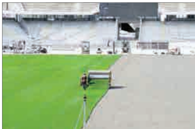
Рис. 13-4 Укладка рулонов газона
