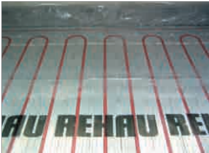
Рис. 4-63 Система укладки труб на теплоизоляционных матах TS-14
