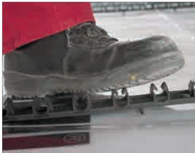
Рис. 4-33 Вдавливание фиксирующих шин RAUFIX в конструкцию пола
