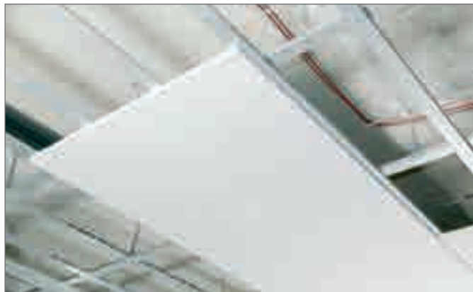
Рис. 5-5 Смонтированный потолочный элемент
