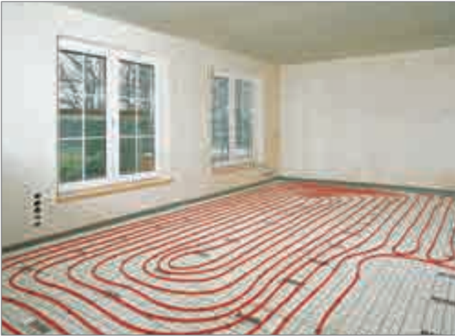
Рис. 4-21 Система крепления труб с помощью гарпун-скоб
