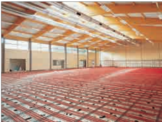
Рис. 11-19 Система напольного отопления виброполов с трубным распределительным коллектором
