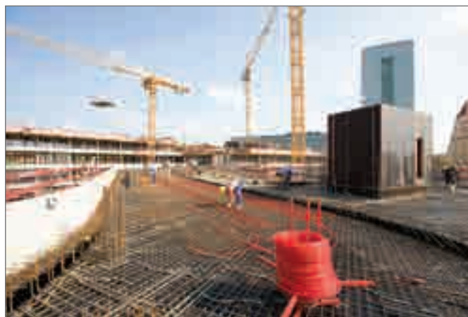
Рис. 9-3 Укладка системы RENAU ВКТ
