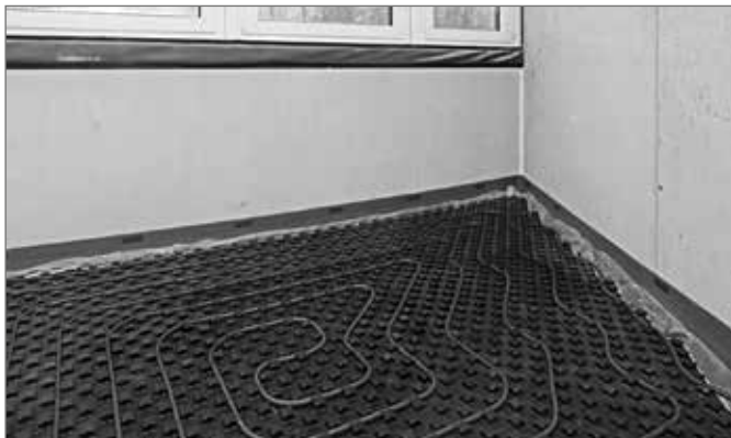
Рис. 15-22 Маты с фиксаторами Varionova с шагозвукоизоляцией 30-2 снизу
