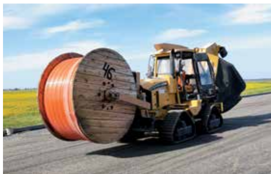
Устройство телекоммуникацион- ной инфраструктуры по дороге «Обход г. Тольятти», Самарская область
