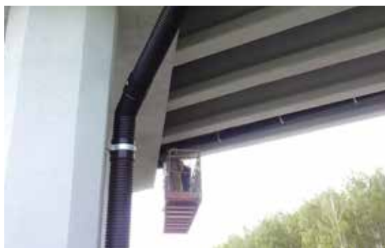
Капитальный ремонт с модернизацией путепровода на автомобильной дороге А1/Е30, г. Минск
