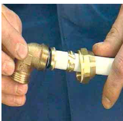
Труба „Coripe“ присоединяется к угольнику 90° „Cofit S“
