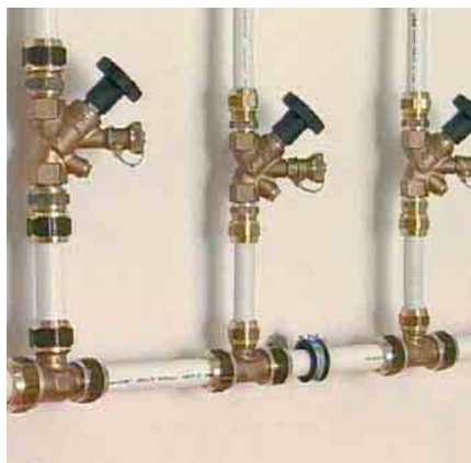
Монтаж арматуры с резьбовым соединением
