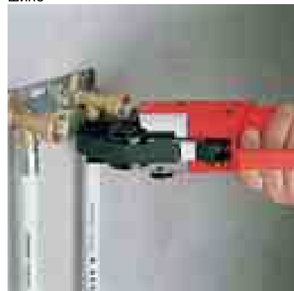
Прессовое соединение на монтажной шине
