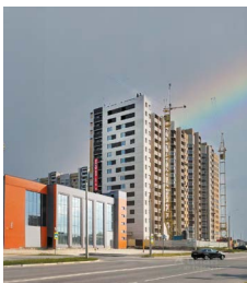
г. Тамбов ул.Селезнёвская, 2Б Многоквартирный жилой дом
