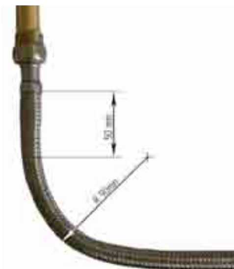
Рисунок 5 Требования к монтажу гибких шлангов
