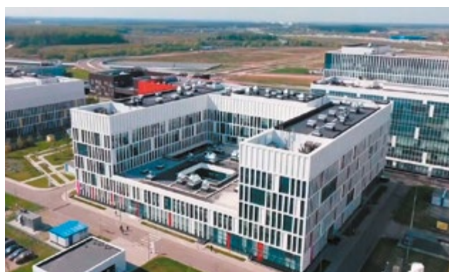
Перинатальный центр «Коммунарка»
