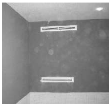
Вид из зала с бассейном перед очисткой отверстий
