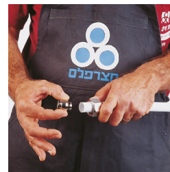
3 Вставка соединителя в трубу
