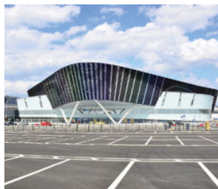
Конгресс-Холл, Екатеринбург-ЭКСПО, г. Екатеринбург
