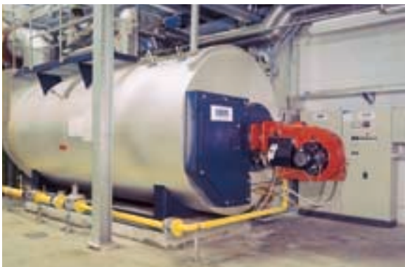
Паровой котел высокого давления UNIVERSAL UL-S для производства насыщенного пара
