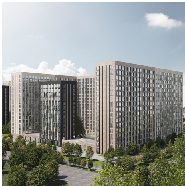
Город: Химки Название объекта: ЖК «Квартал Ивакино»
