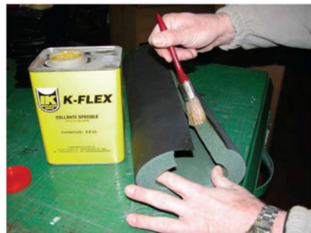
Нанесите клей K-FLEX K-414 на стороны шва теплоизоляционного материала.
