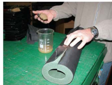
После прочного соединения шва теплоизоляционного материала нанесите клей K-FLEX K-414 на поверхность нахлеста...
