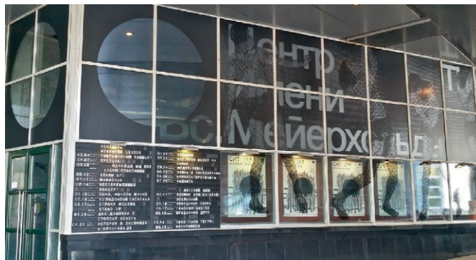
Театральный центр им. Вс. Мейерхольда, г. Москва
