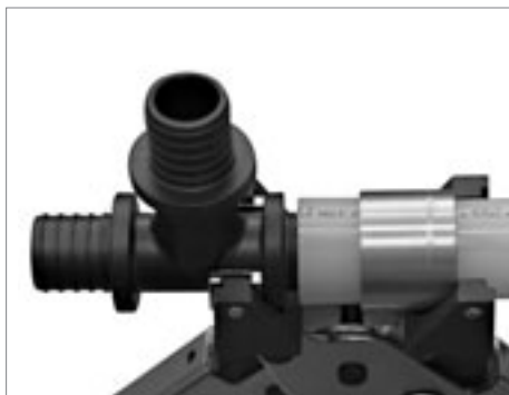
Монтаж отводов и тройников из PPSU \varnothing 32 \times 4,4
