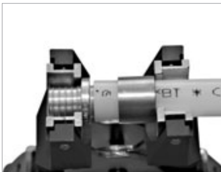
Монтаж двухсторонних соединителей \varnothing 14 \times 2 , \varnothing 18 \times 2 , \varnothing 18 \times 2,5
