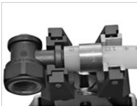
Монтаж отводов фиксируемых из PPSU
