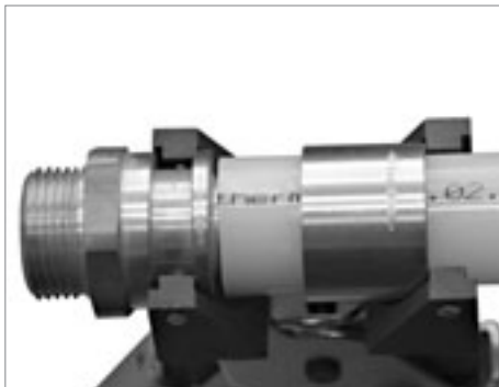
Монтаж соединителей с наружной и внутренней резьбой \varnothing 32 \times 4,4
