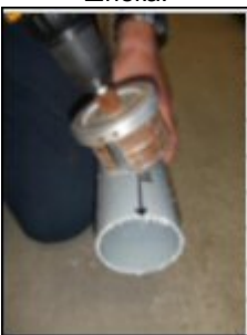
4. Наклоните сверло к себе и рассверлите отверстие.
