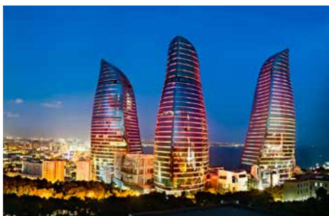
Flame Towers - Азербайджан - Mini Canal
