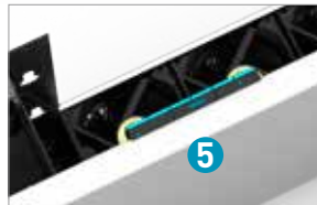
Установите кожу на конвектор, но без решётки. Разместите блок управления на фронтальной панели.
