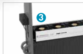
Подключите блок DBH к контроллеру и закрепите его на теплообменнике.
