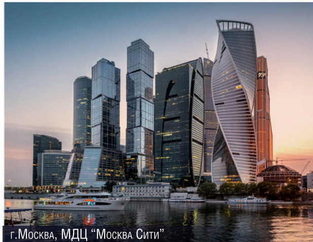
г.Москва, МДЦ "Москва Сити"
