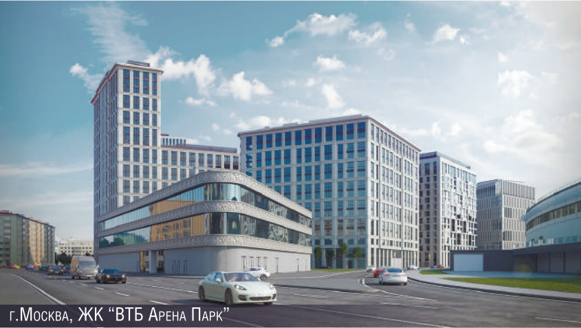
г.Москва, ЖК "ВТБ Арена Парк"
