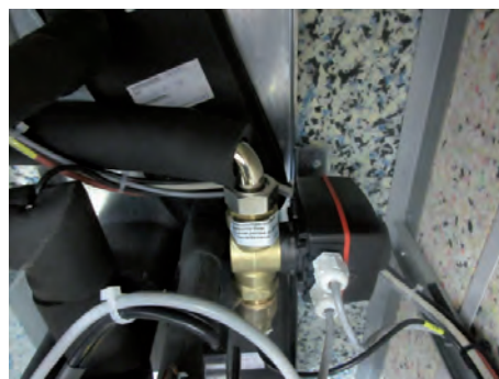
Підключення подачі теплового насоса
