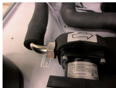
Підключення зворотки теплового насоса
