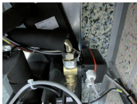
Підключення подачі теплового насоса
