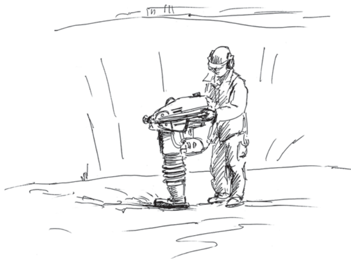
Рис. 5.1. Уплотнение грунта основания траншеи
