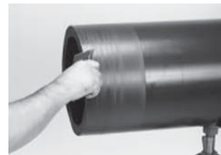
Фото 4.2.6. Снятие фаски для облегчения надевания муфты
