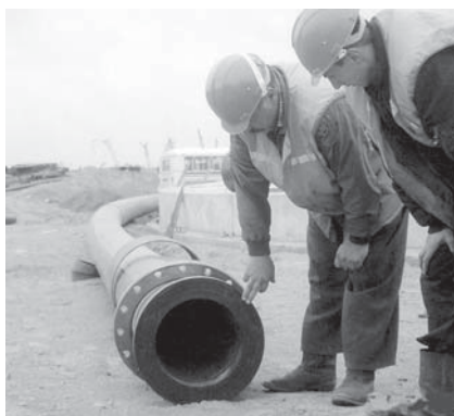
Фото 1.4. Разъемное фланцевое соединение ПЭ труб
