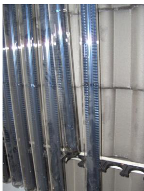
Рисунок 23: Вставка трубы в держатель под наклоном
