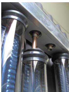
Рисунок 24: Вставка трубы
