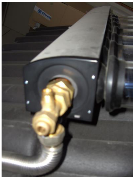
Ввод трубы в черепичную кровлю
