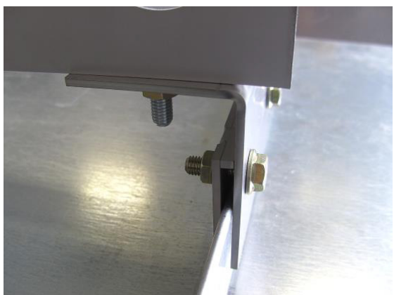
Рисунок 8: Монтаж на Stehfalz
