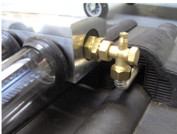
Рисунок 29: Для трубопровода используйте вентиляцию для кровли
