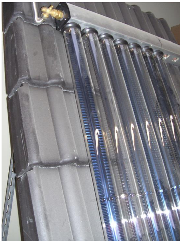
Рисунок 17: Монтаж корпуса с гильзой
