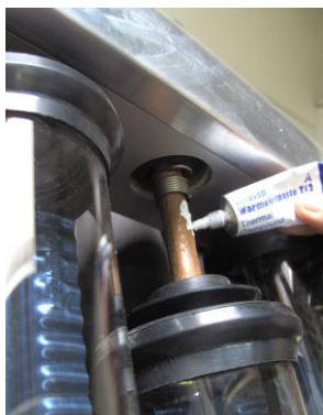
Рисунок 22: Нанесение пасты
