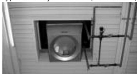
Рис.5. Агрегат TopVent® commercial с гидравлическим модулем
