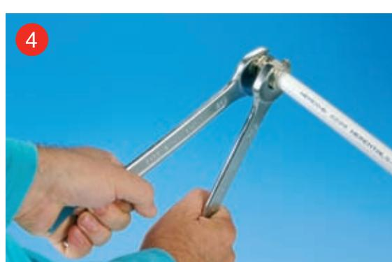
Накрутите гайку на ниппель, клапан или коллектор до рекомендованного производителем усилия. Используйте только открытые ключи.
